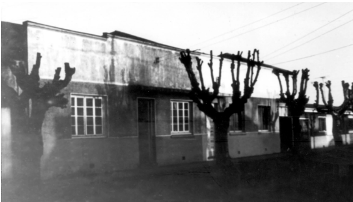
Figura N° 11: Vista casa familia Ackerknecht Schneider en Lautaro a comienzos de siglo y estado actual (1992) Abb. Nr.11: Ansicht des Wohnhauses der Familie Ackerknecht-Schneider in Lautaro, zu Beginn des 20. Jahrhunderts und aktueller Zustand (1992)
